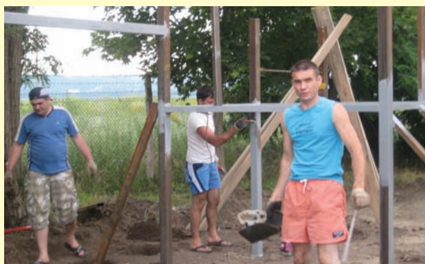
Ojcowie przy budowie placu zabaw dla maluchów
