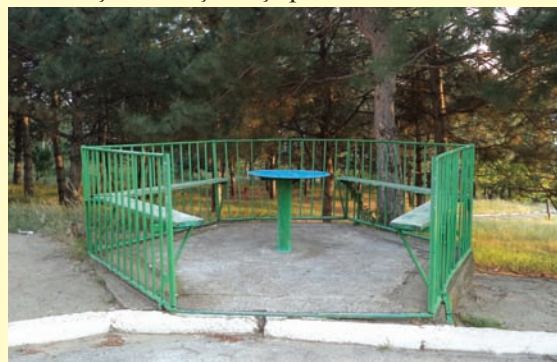
Acest pavilion va fi acoperit și reparat în cadrul inițiativei tinerilor din Corjova
